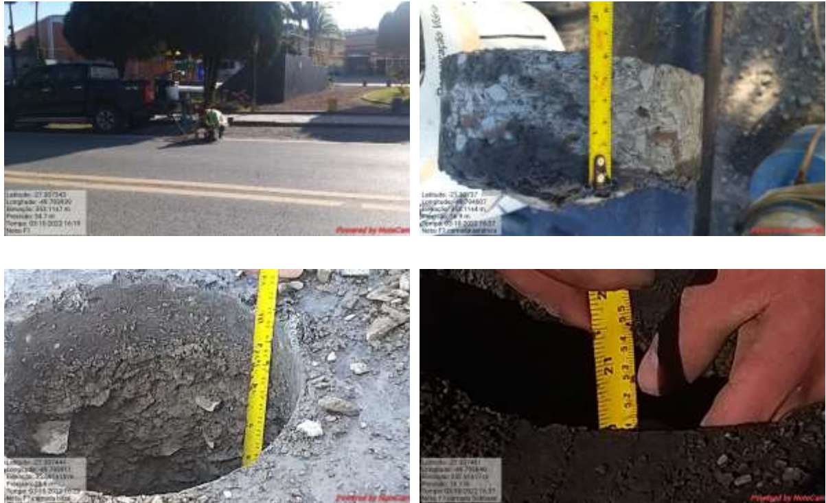
Figura 14 – Relatório Fotográfico – Furo 1
