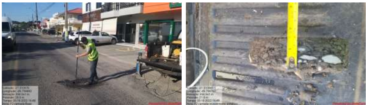
Figura 15 – Relatório fotográfico – Furo 2
